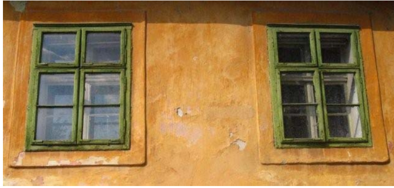
pic. 2 windows on a house in Svätý Jur
